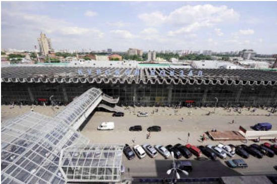
Nhà ga Kursk với toàn bộ phần mái là tấm lợp polymer
